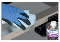
1. Reinigen Sie die zu verklebenden Flächen entsprechend. Diese sollten fettund staubfrei sein, um eine dauerhafte Verklebung sicherzustellen. Hierzu empfehlen wir eine Reinigung mit beko Allclean.
