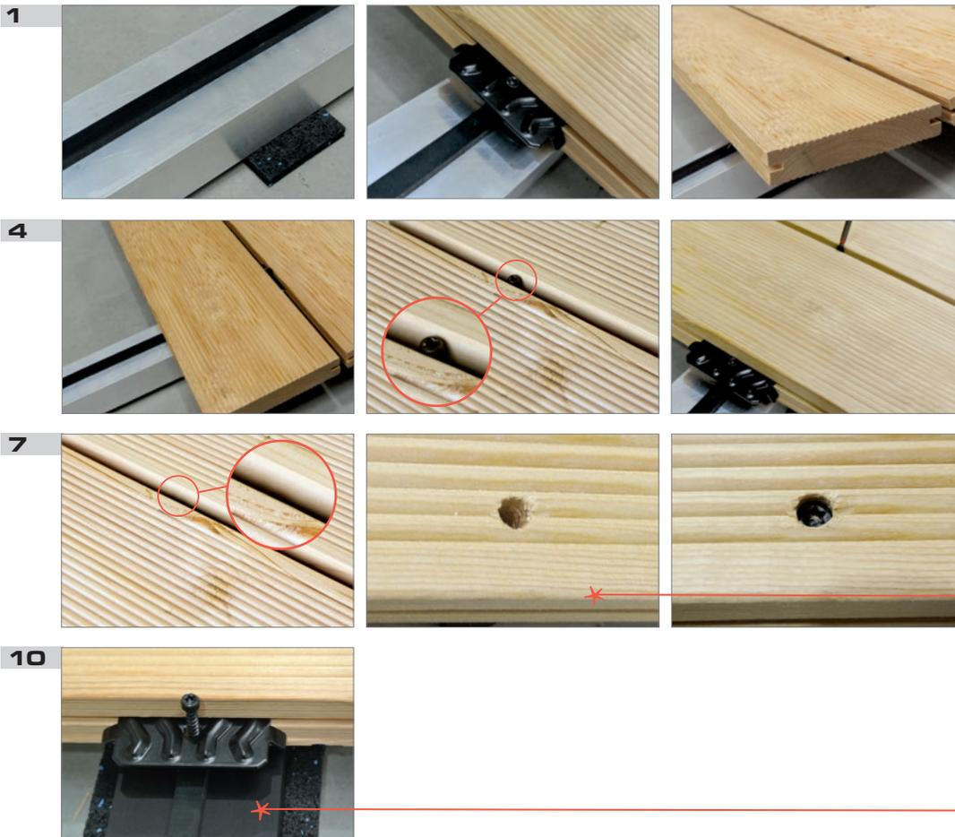
Abschlussdielen mit einem 6,5-mm-Bohrer ca. 4 mm tief vorbohren, damit der Schraubenkopf versenkt werden kann.
